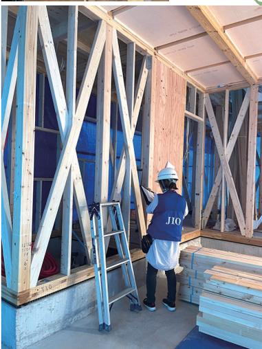
JIOによる金物検査も内部工事前に実施します
