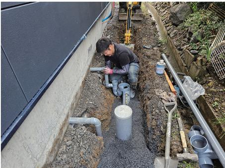
水道引き込み工事をおこない、給排水工事が完了です
