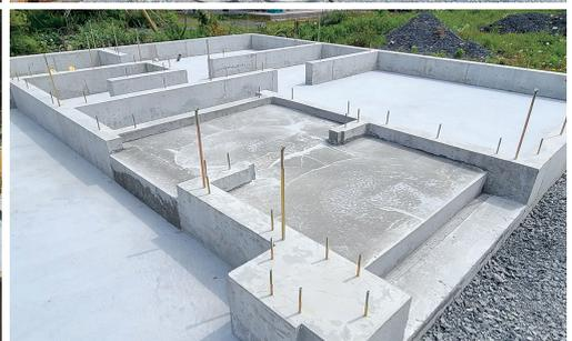
碎石敷き→捨てコンクリート→配筋・型枠工事→打設工事→型枠を外して仕上げ、基礎の完成です
