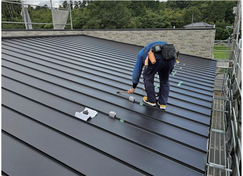
屋根ルーフィングの上にガルバリウム鋼板を施工して屋根を完成させていきます。スタイリッシュな陸屋根風片流れ屋根の完成です
